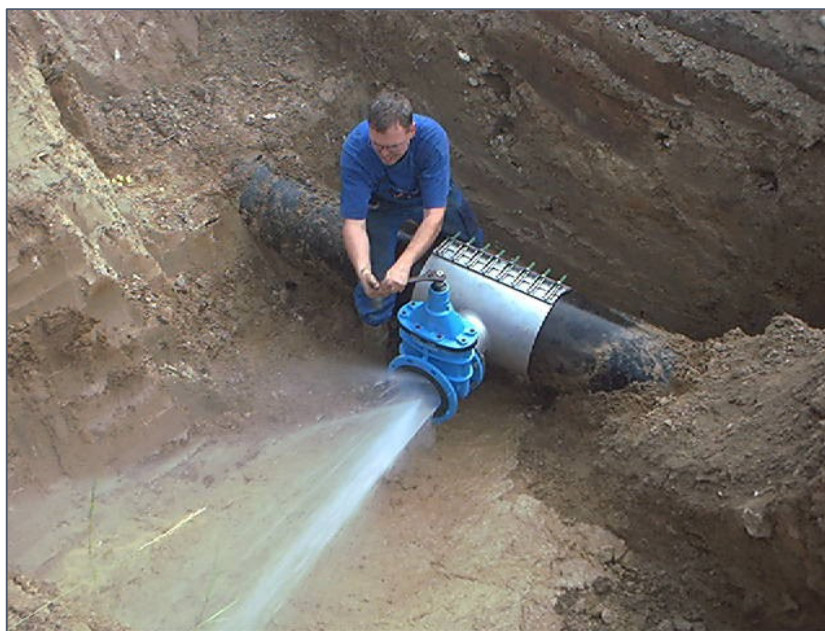
DN150 anboring på ø400 mm støbejernsledning for Holbæk Kommune
