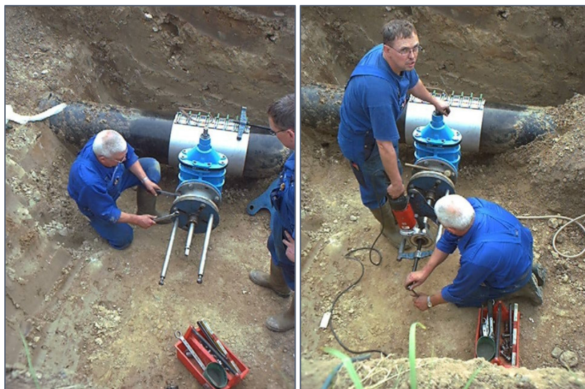
DN150 anboring på ø400 mm støbejernsledning for Holbæk Kommune
